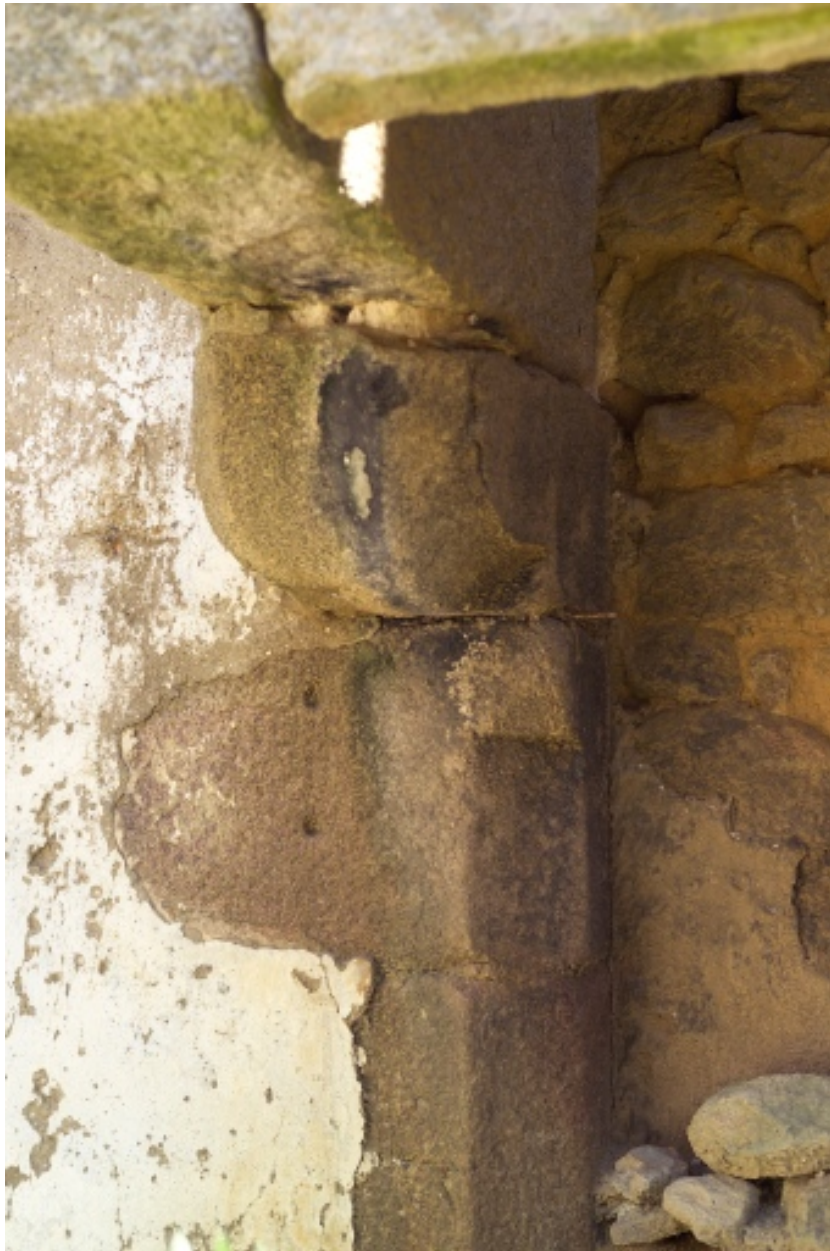
Cheminée de la partie est, détail du jambage.
