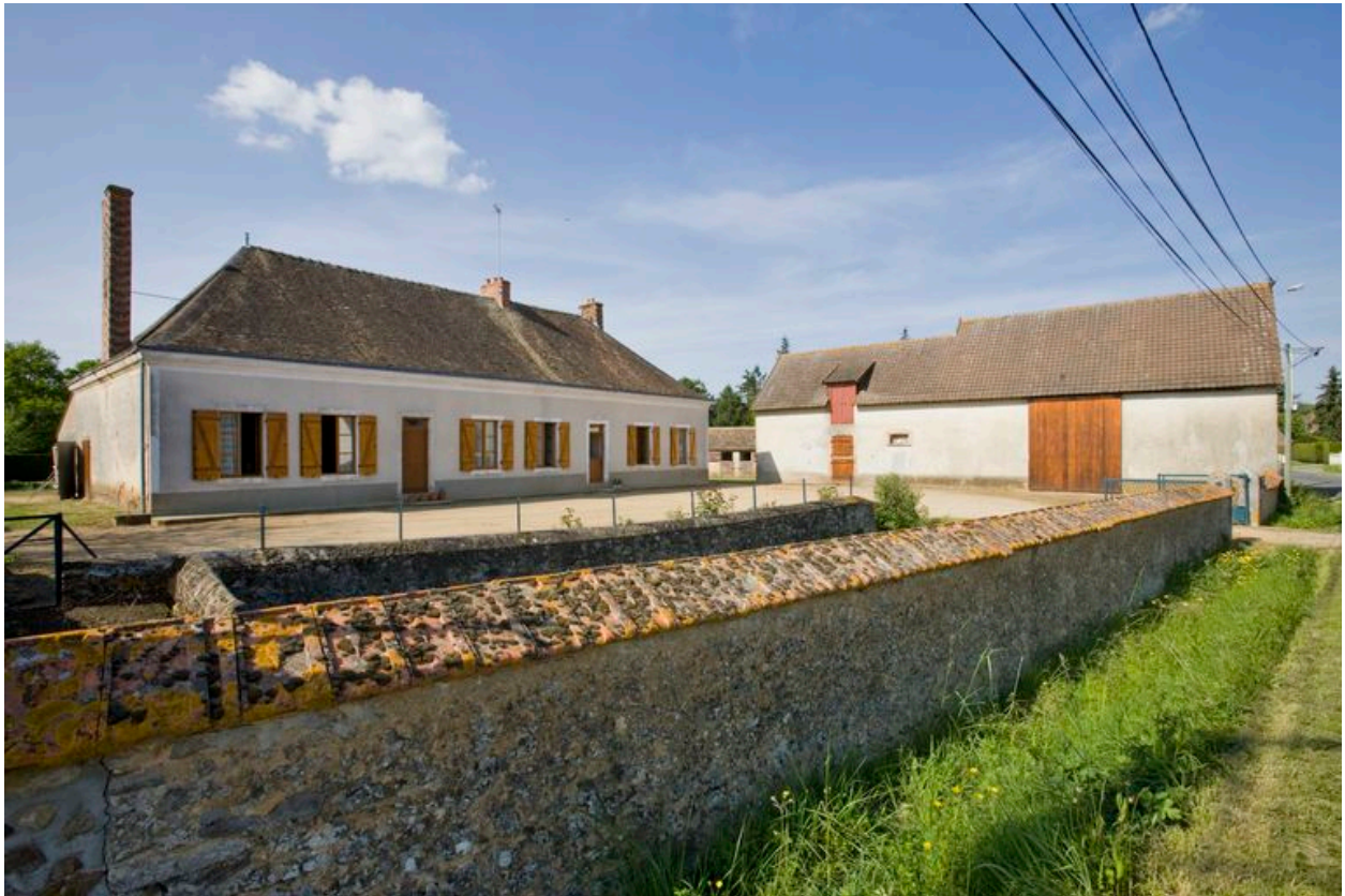
Vue générale depuis le sud.
