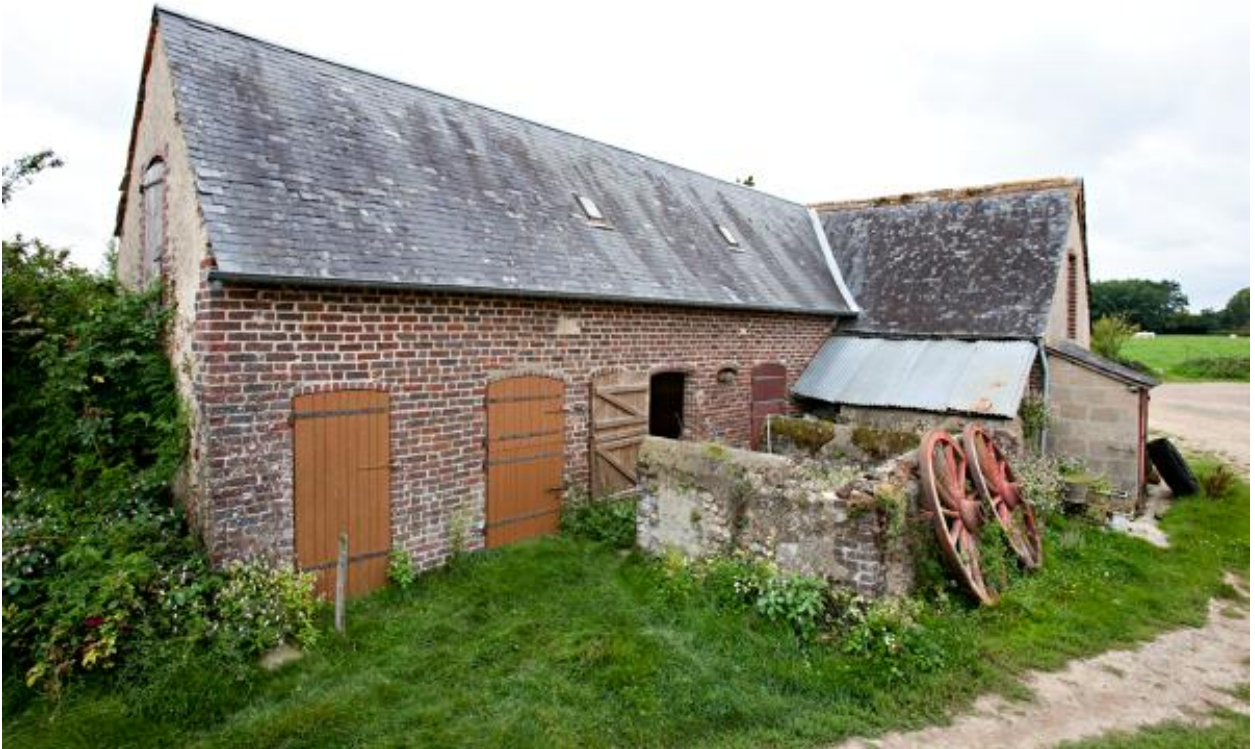
Laiterie 2 (à gauche) et toit à porcs, avec muret de briques délimitant une courette.
