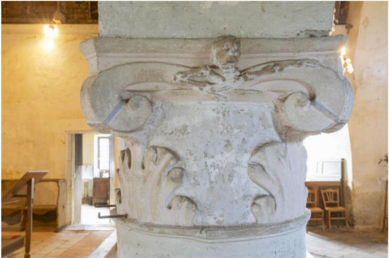
Le pilier du bas-côté nord, détail du chapiteau.
