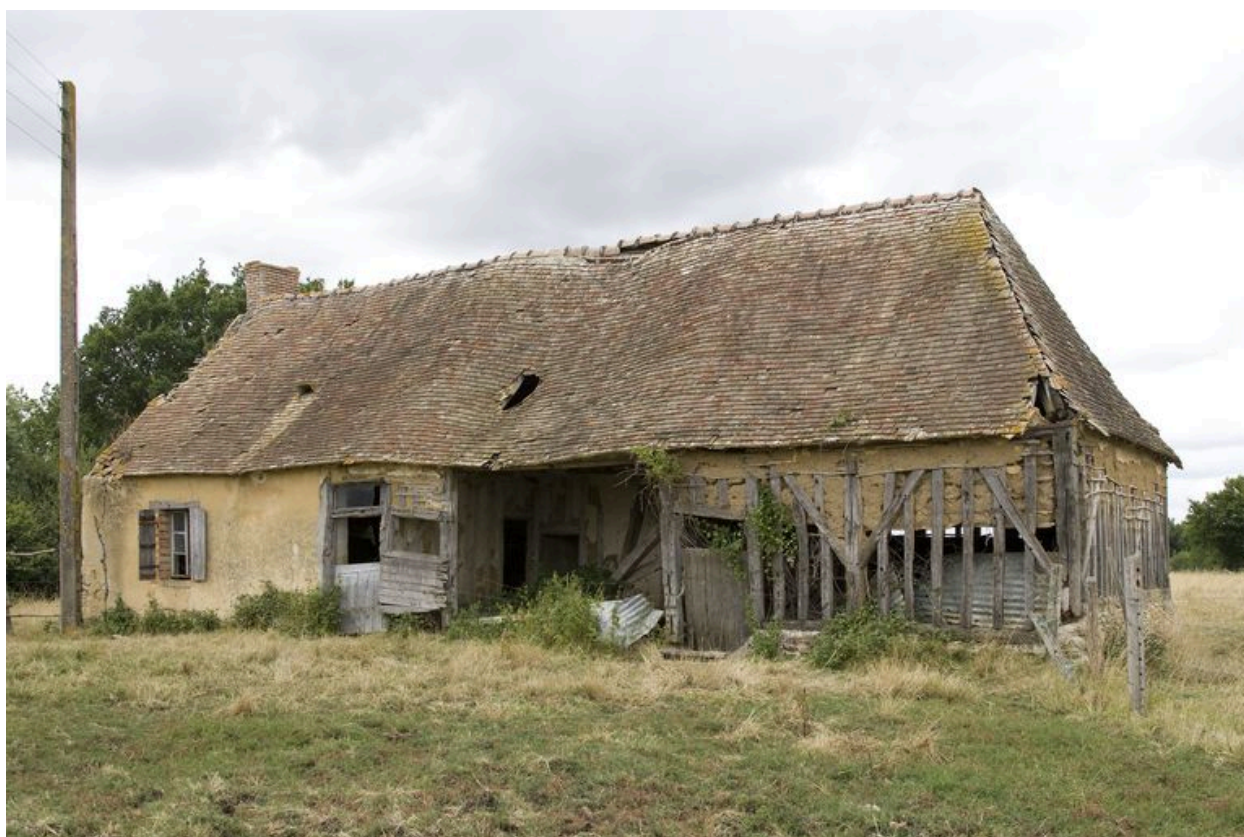
Élévation antérieure du logis.
