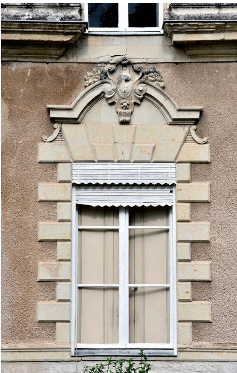
Détails d'une baie de la façade est.
