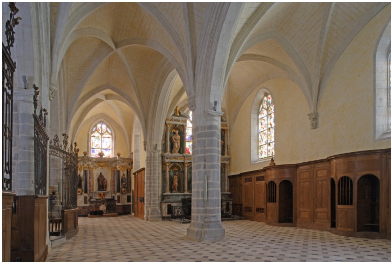
Choeur, collatéraux droit après restauration : vue d'ensemble depuis le bras droit du transept.
