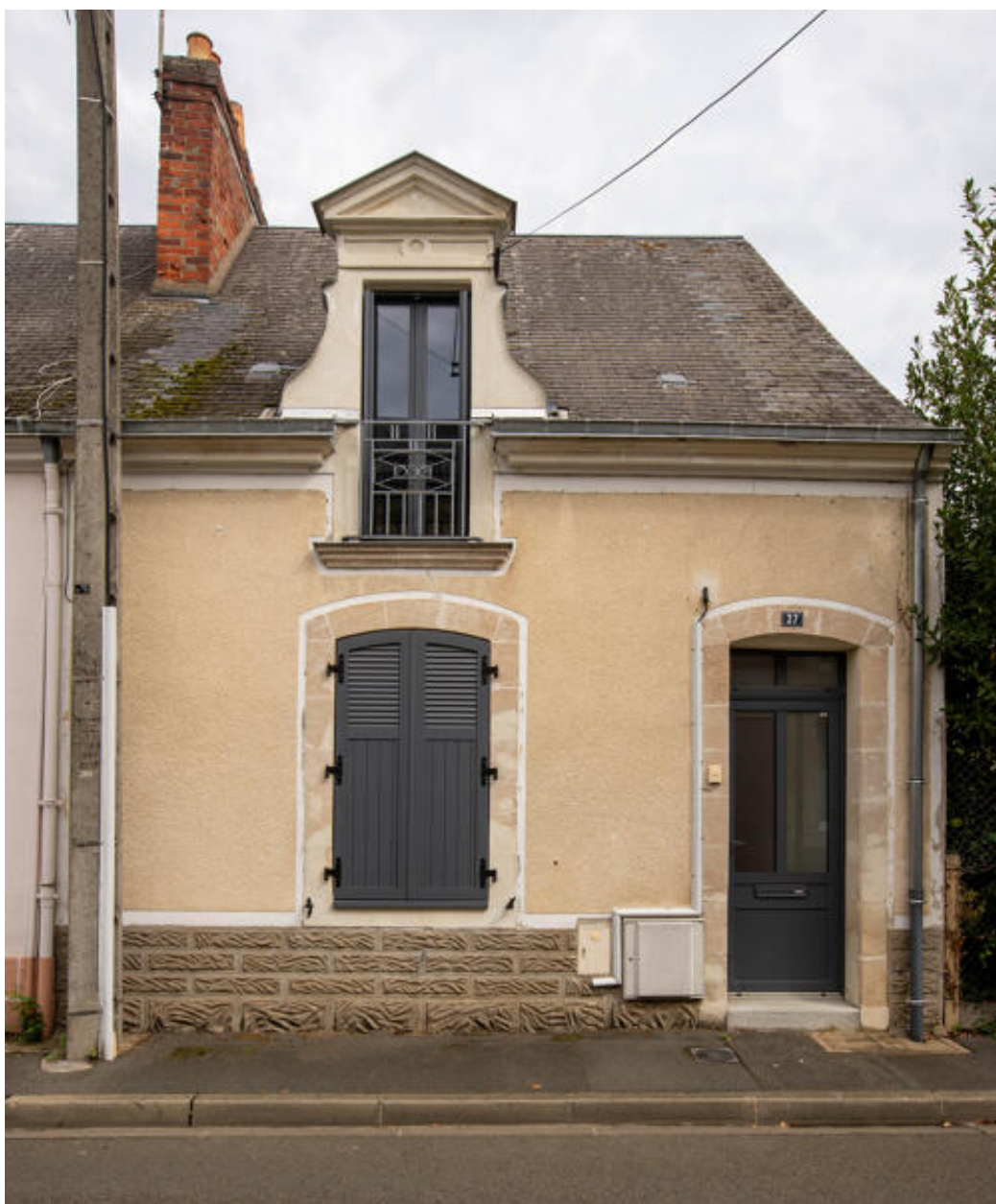
Vue d'une mancelle rue du Ponceau.
