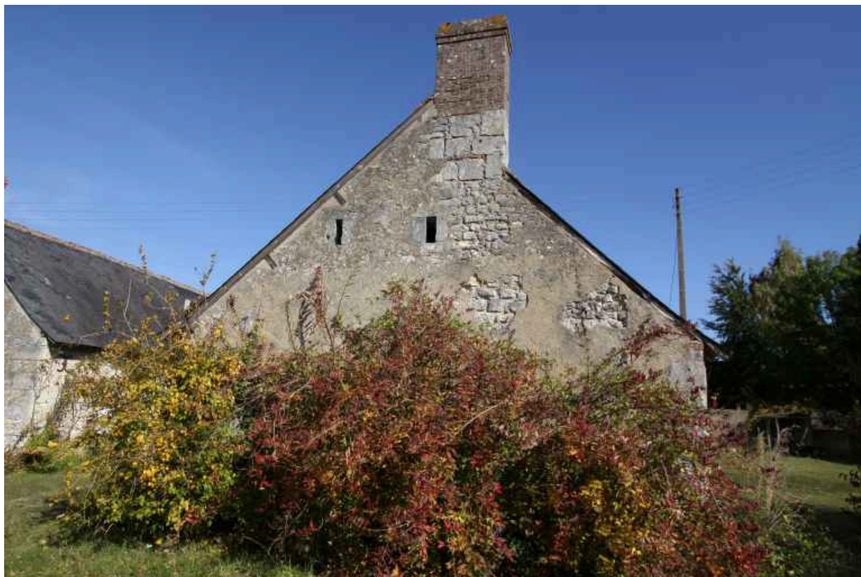
Maison 3 : pignon ouest.
