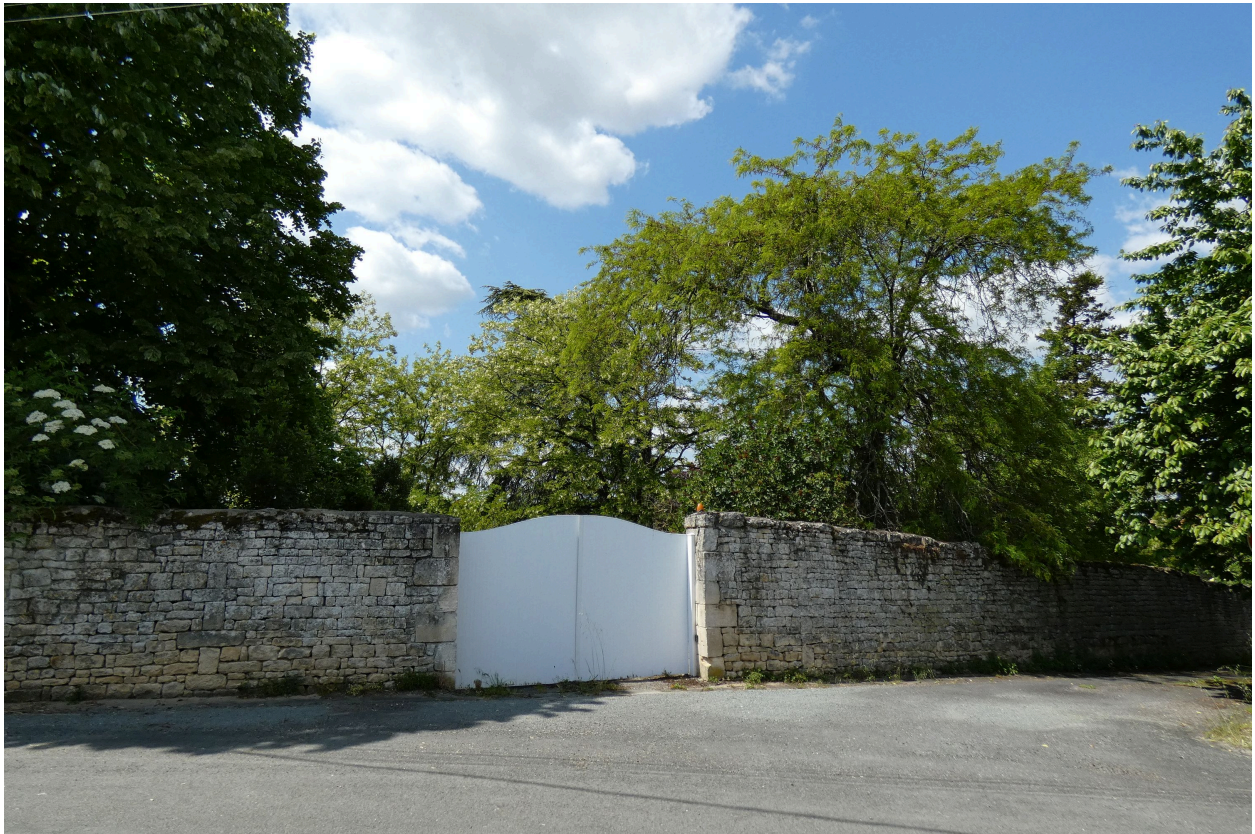
Le mur de clôture du parc et le portail, au sud-est, rue de la Cantardière.
