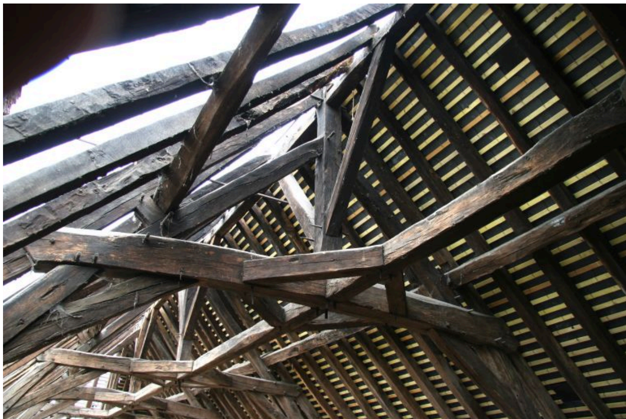
Charpente de la dépendance ancienne : double faîtages.
