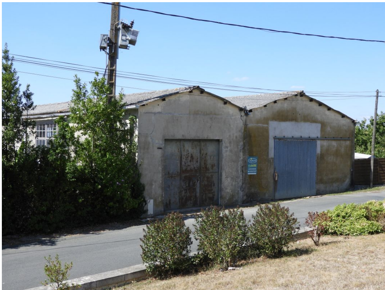
Bâtiments annexes le long de la rue des Jardins, vus depuis le sud-est.
