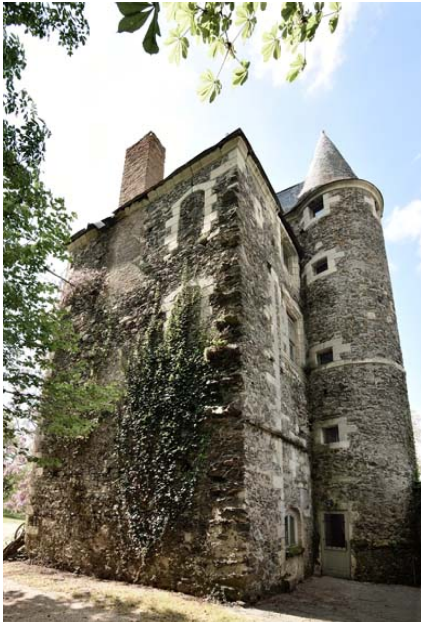
Mantelon. Château. Vue du châtelet d'entrée.
