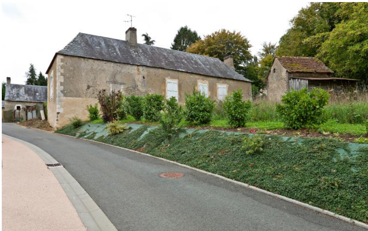
Façade postérieure en surplomb.
