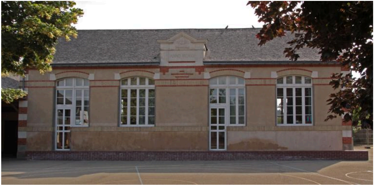
1, ruelle de l'École : école.
