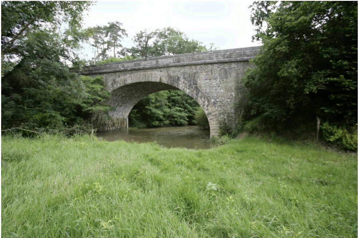
Vue d'aval depuis la rive gauche.
