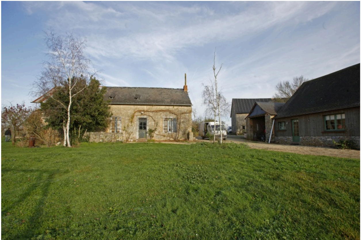
Le logis, la seconde étable-grange, la remise et le logis contemporain vus depuis le sud-ouest.
