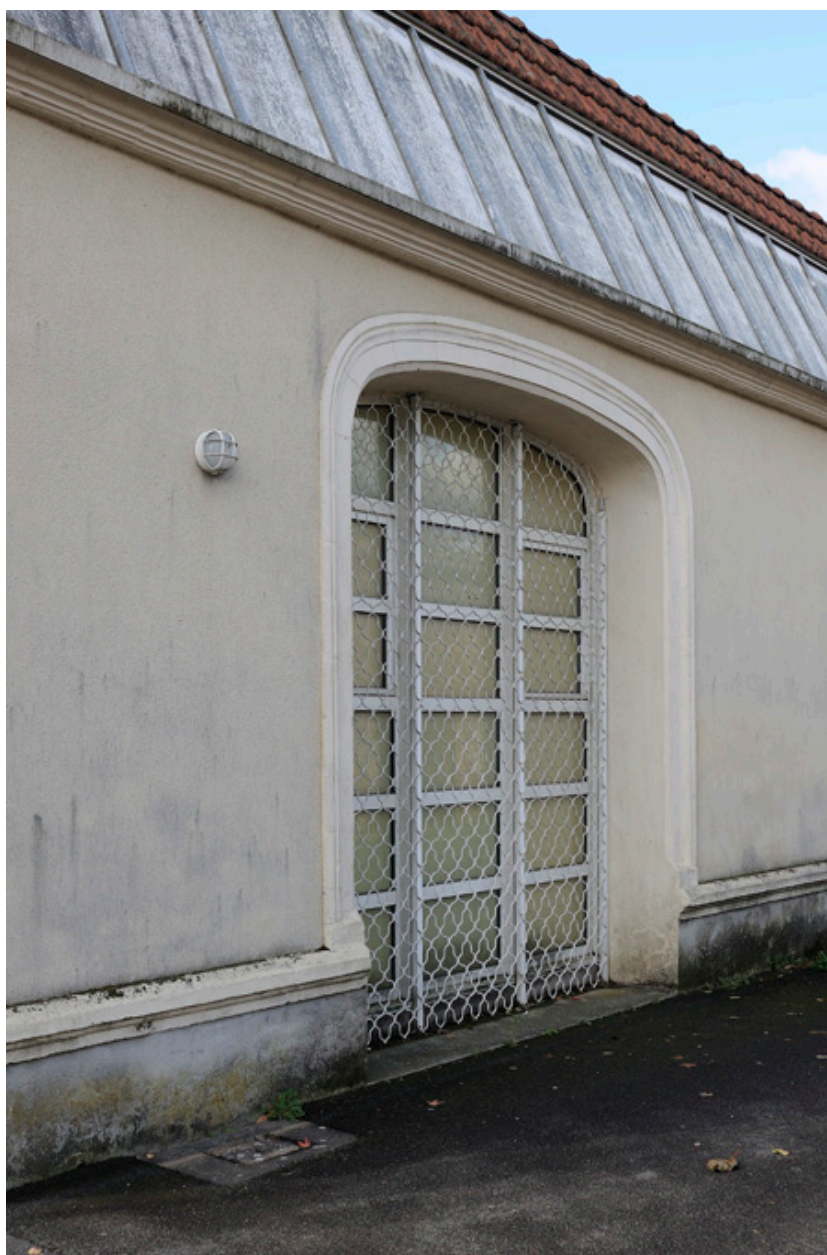
Détail d'une baie, située sur la façade principale.
