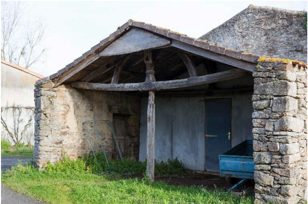
Maison avec charpente ouvragée (remploi), ZR01-135, cadastre 2018.
