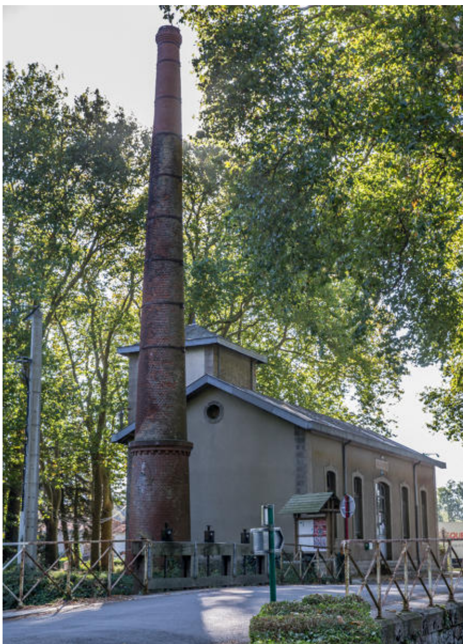
Vue de la Machinerie depuis la rue du Canal.
