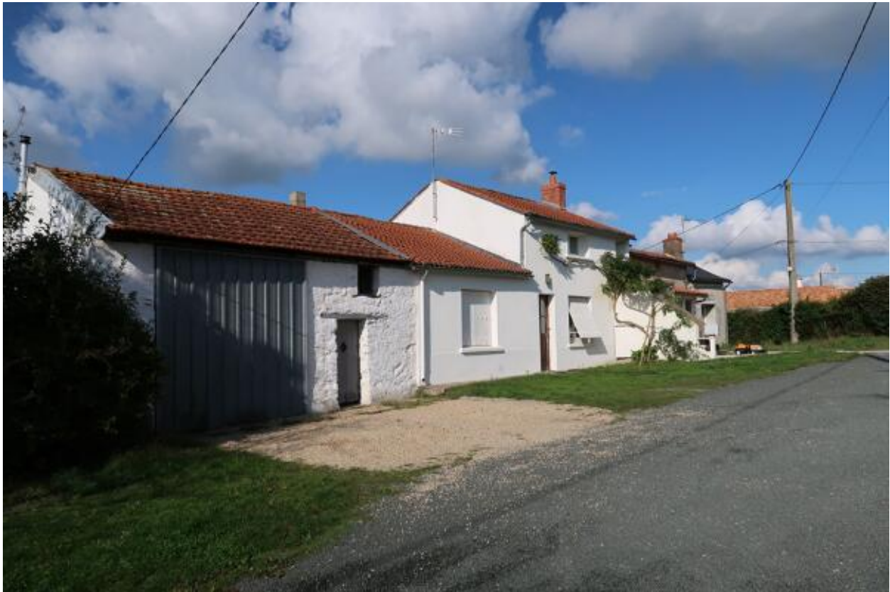
Vue de la rangée de fermes n°1 depuis le sud-ouest.
