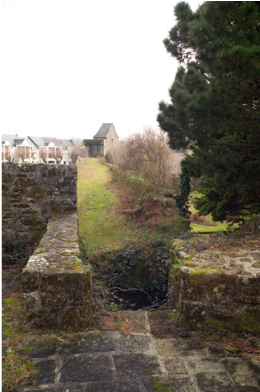
Chemin de ronde voisin de la tour est.
