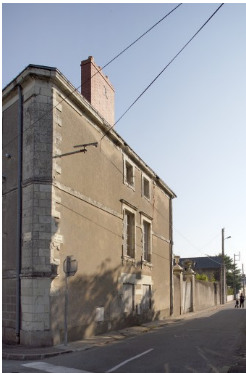
Rue de la Vierge, face nord, vue prise de l'ouest vers l'est.
