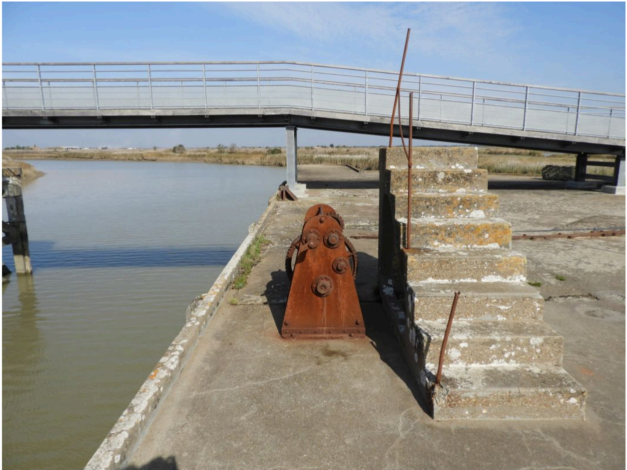
Vestiges du système de manoeuvre du tablier mobile, sur l'éperon de la rive gauche.
