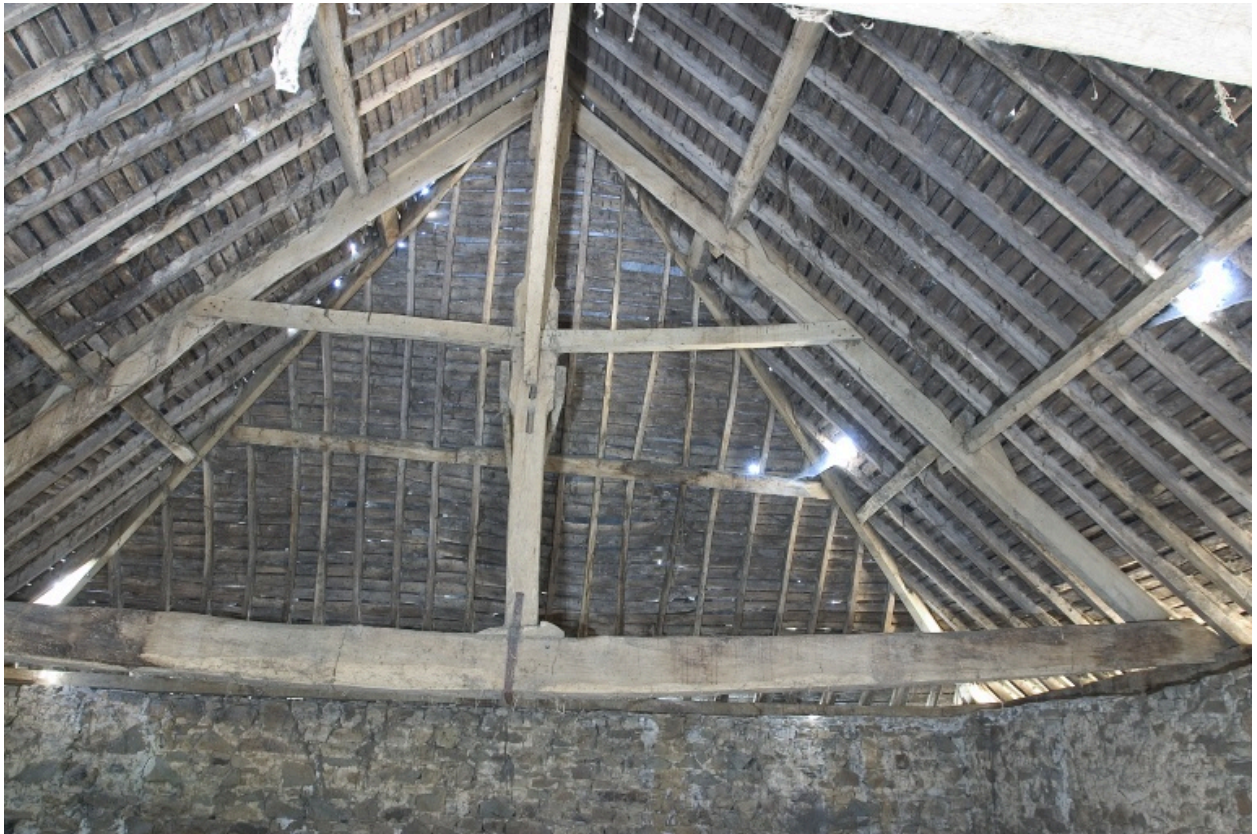
Intérieur de l'étable à vaches-grange. La charpente : ferme ouest.
