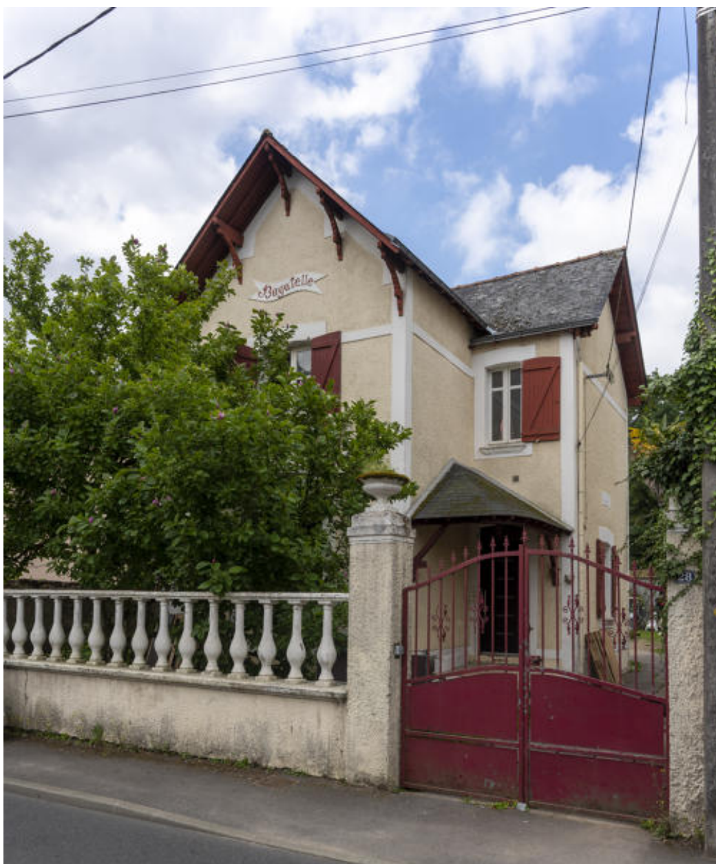
Maison "La Bagatelle", 28 rue des Ponts.
