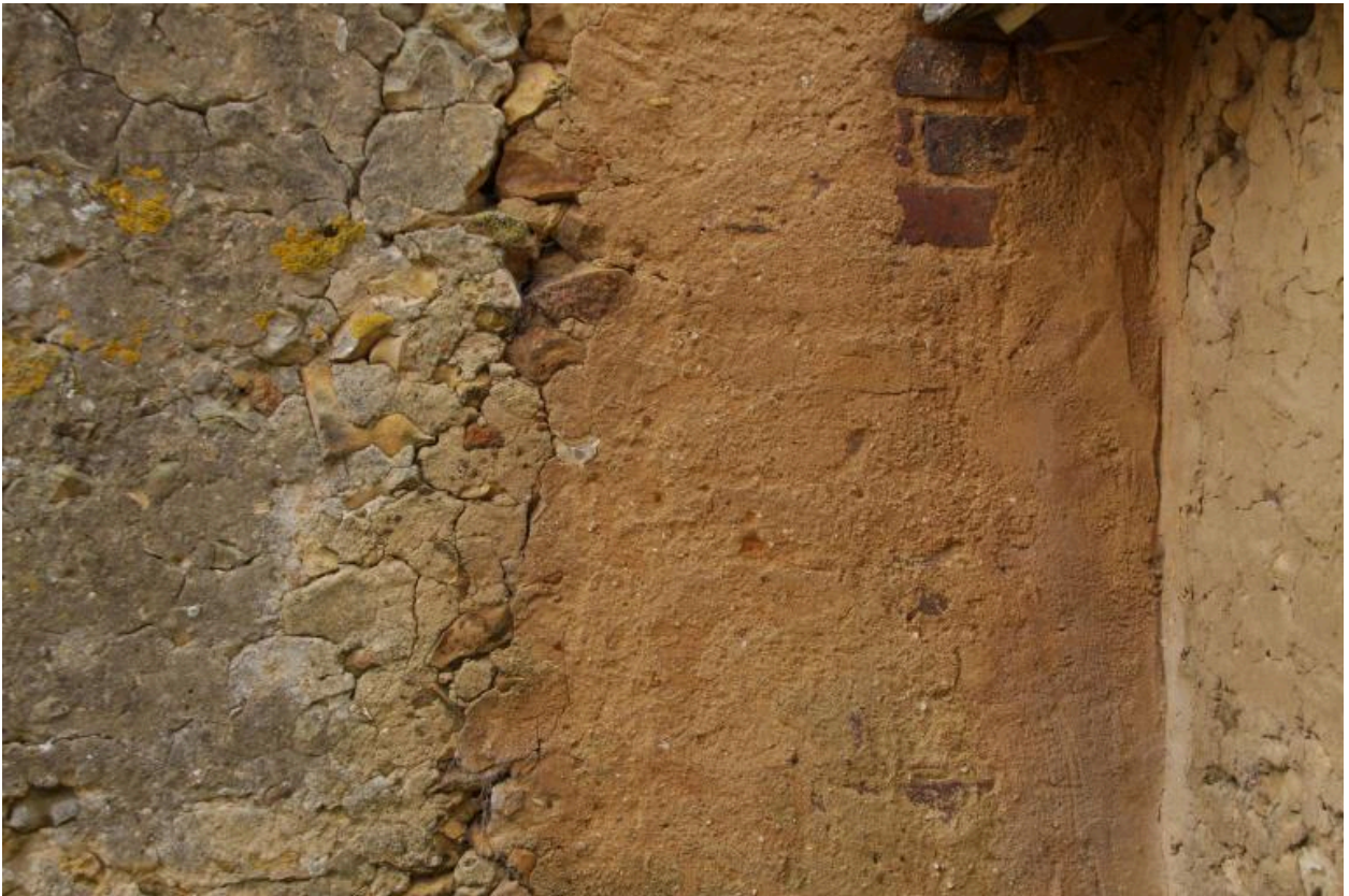
Détail d'enduits (mur-pignon ouest de la maison avec four).
