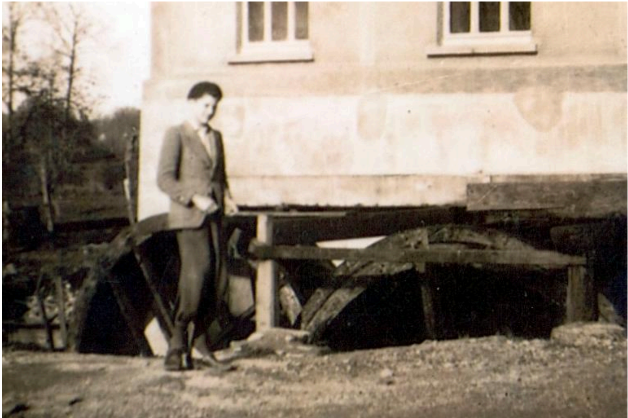
Les roues peu avant leur démontage, 1947.
