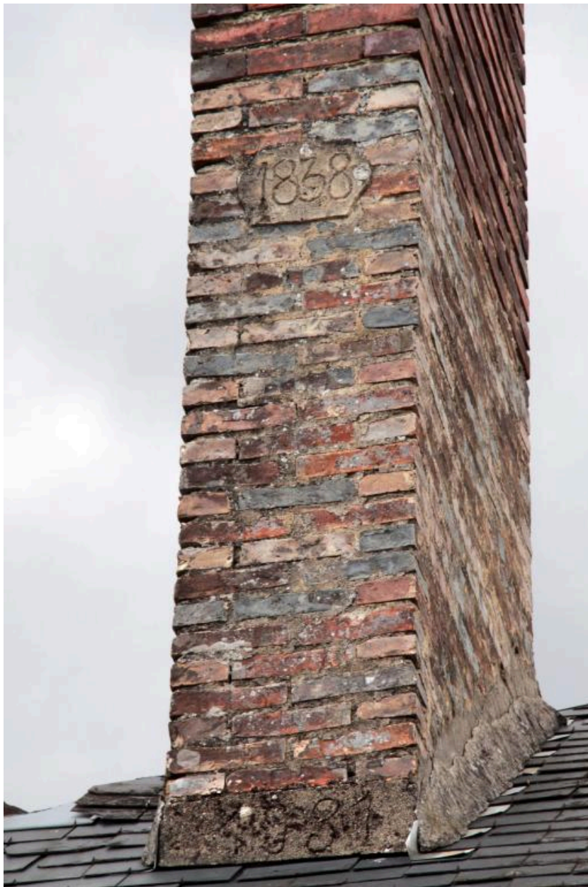
Maison du moulin, cheminée centrale (dates portées sur la souche : 1838 et 1931).
