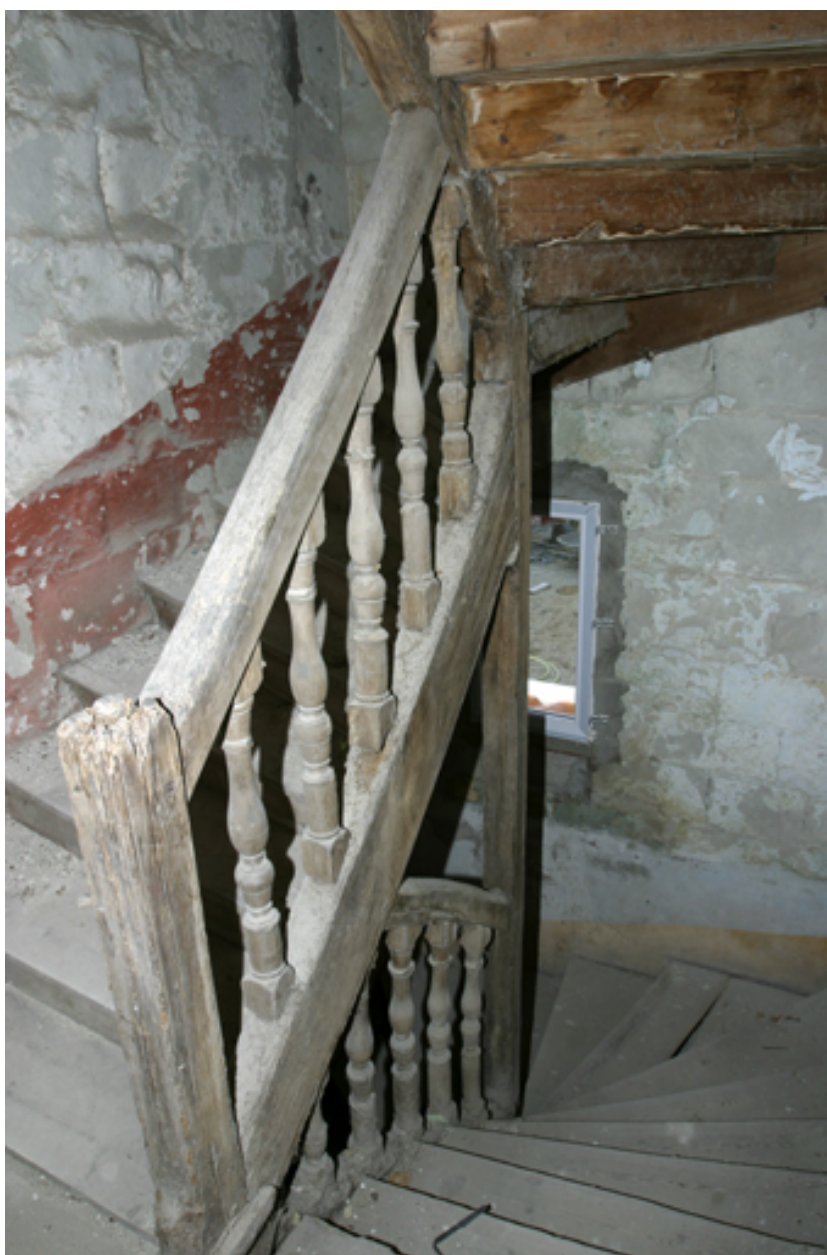
L' escalier accessible depuis l'allée, vue prise du palier du premier étage.
