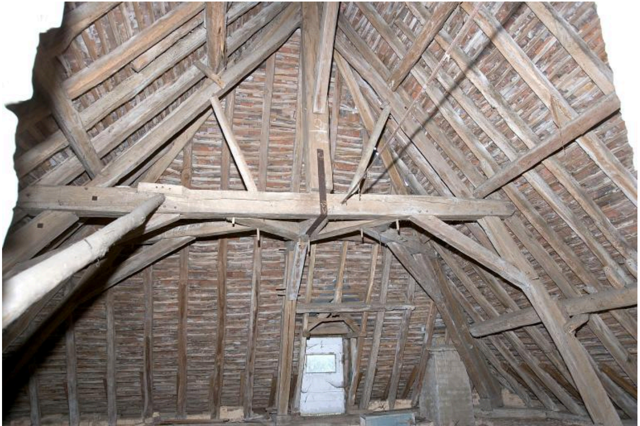
Le pavillon, comble, détail de la charpente, 2007.
