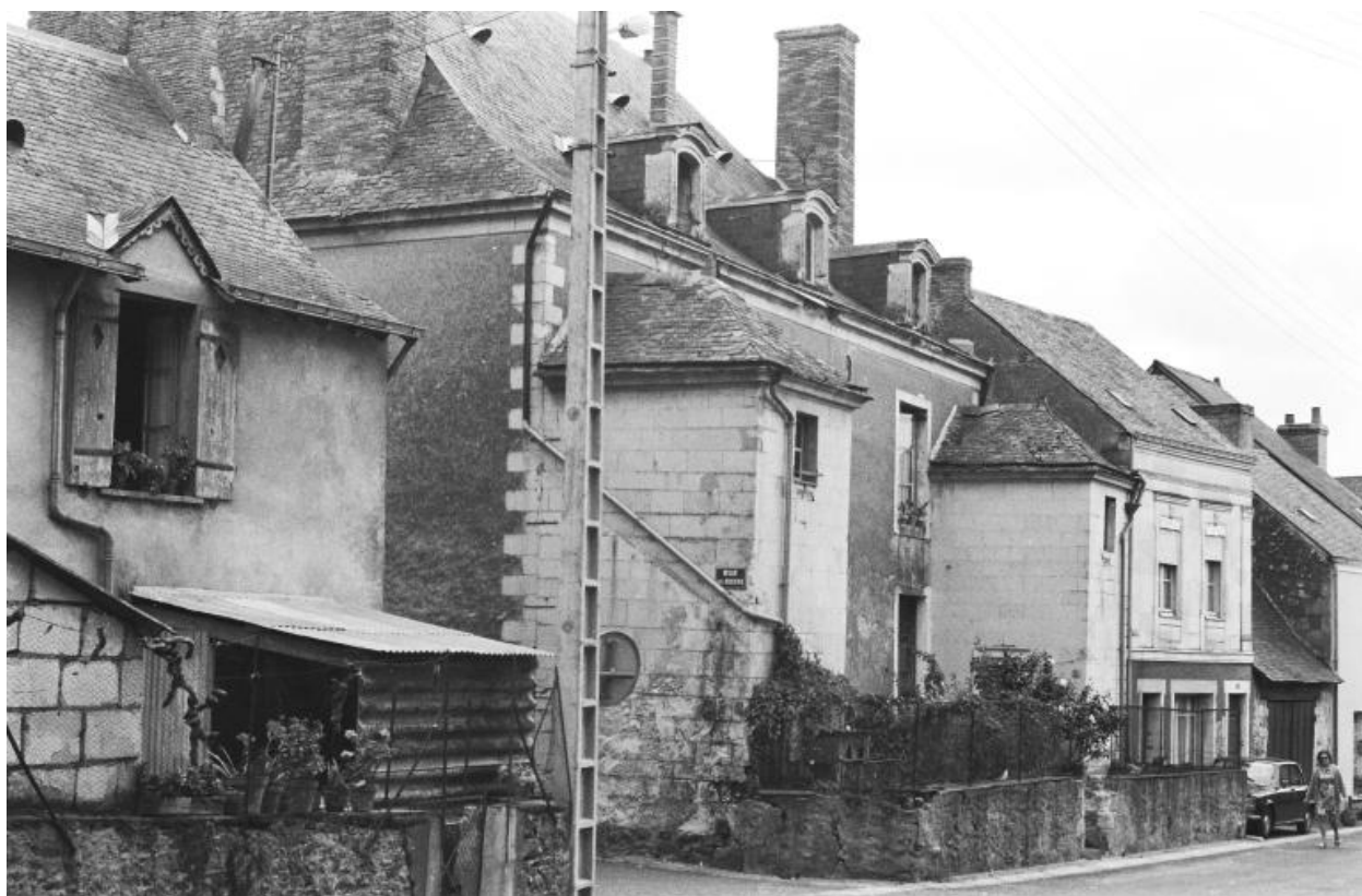
Série de façades postérieures.
