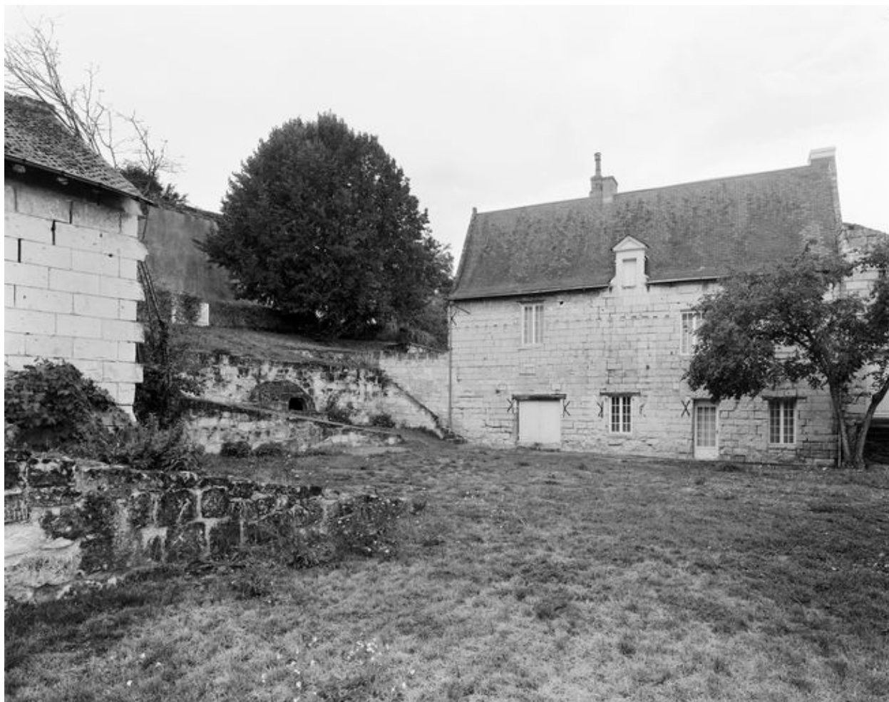
Vue d'ensemble de la façade orientale (autrefois sur cour intérieure), en 1996.
