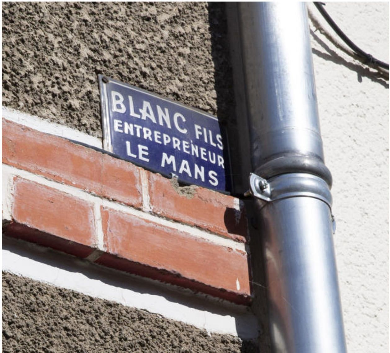
Vue de la plaque d'entrepreneur (Blanc) sur une maison de style années 1930 boulevard Carnot.
