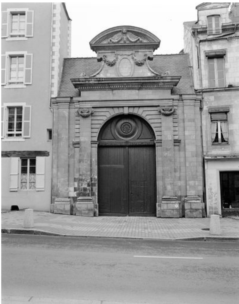
Abbaye, cour d'honneur, corps d'entrée : portail sur la rue.
