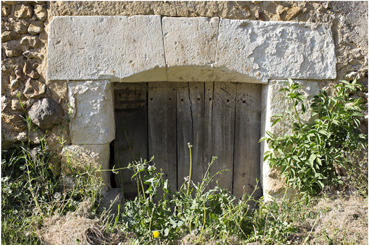
Façade sud, détail : entrée de cave (côté gauche).
