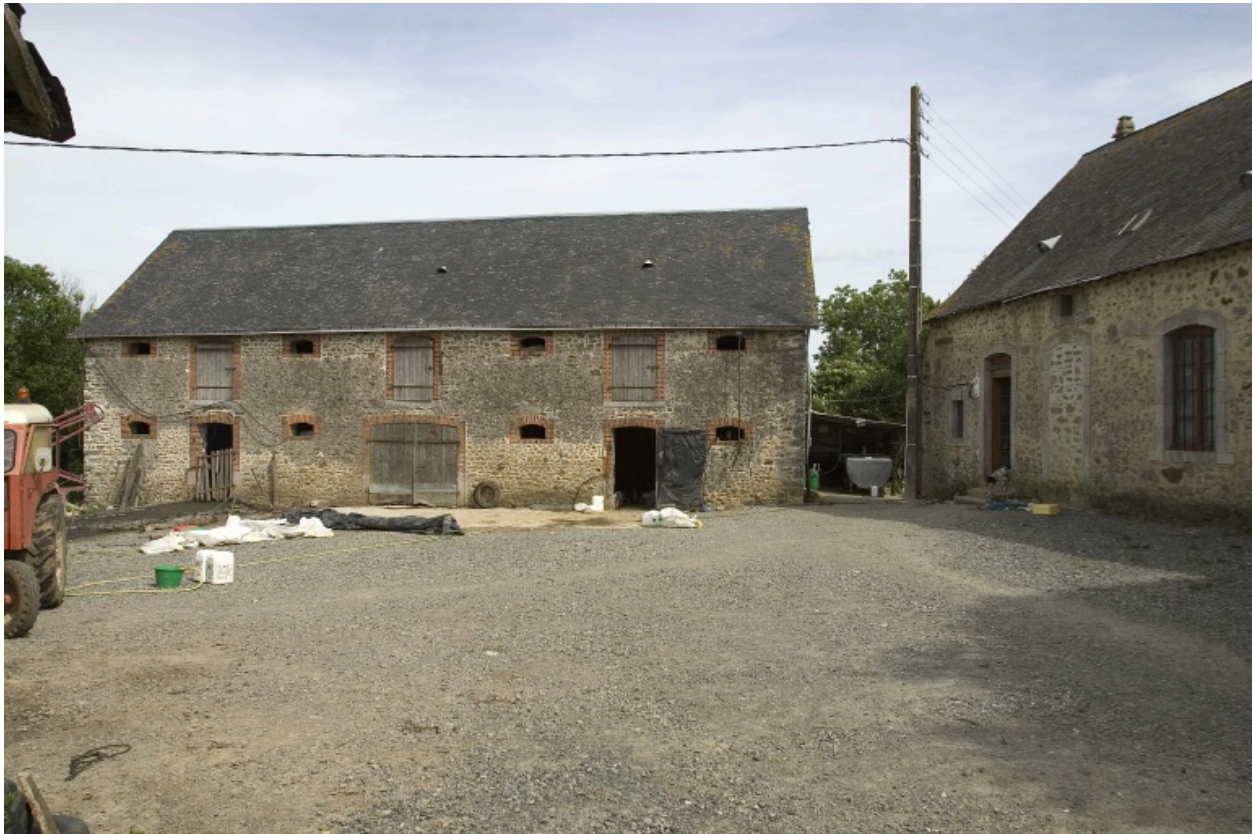
L'étable et le logis vus depuis l'ouest.
