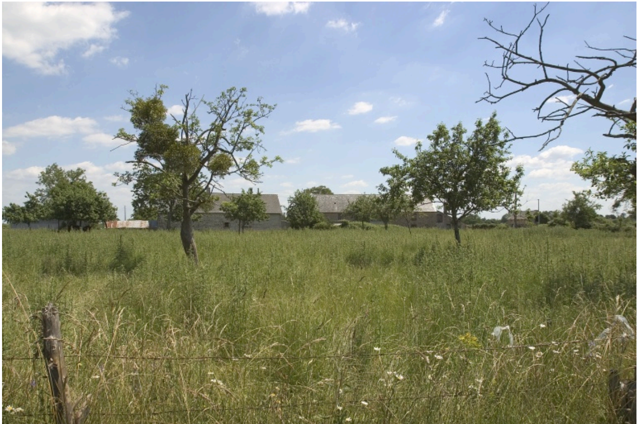
Vue d'ensemble depuis la route au nord-ouest : le logis, l'étable-grange, la remise.
