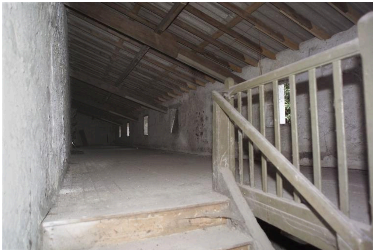
Le corps en appentis situé au sud du corps secondaire, vue du comble.
