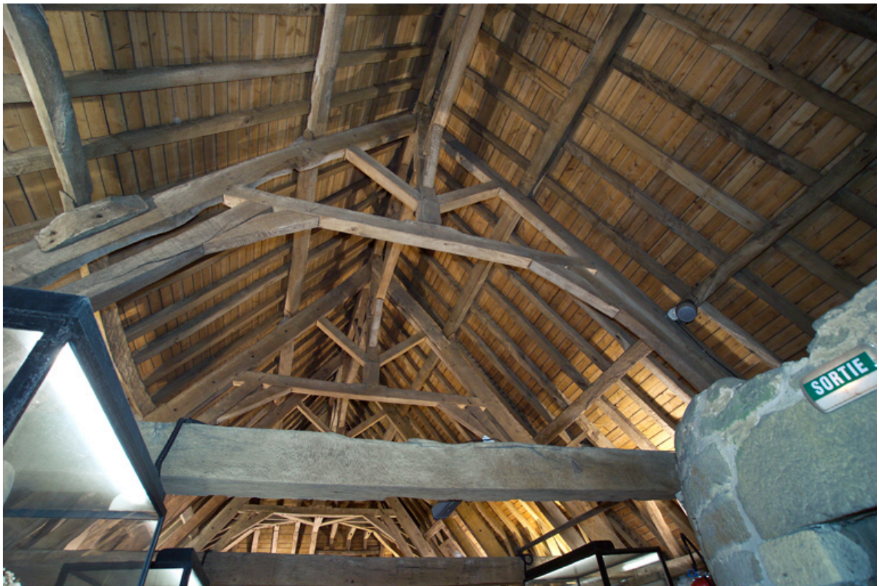
Vue de la charpente.
