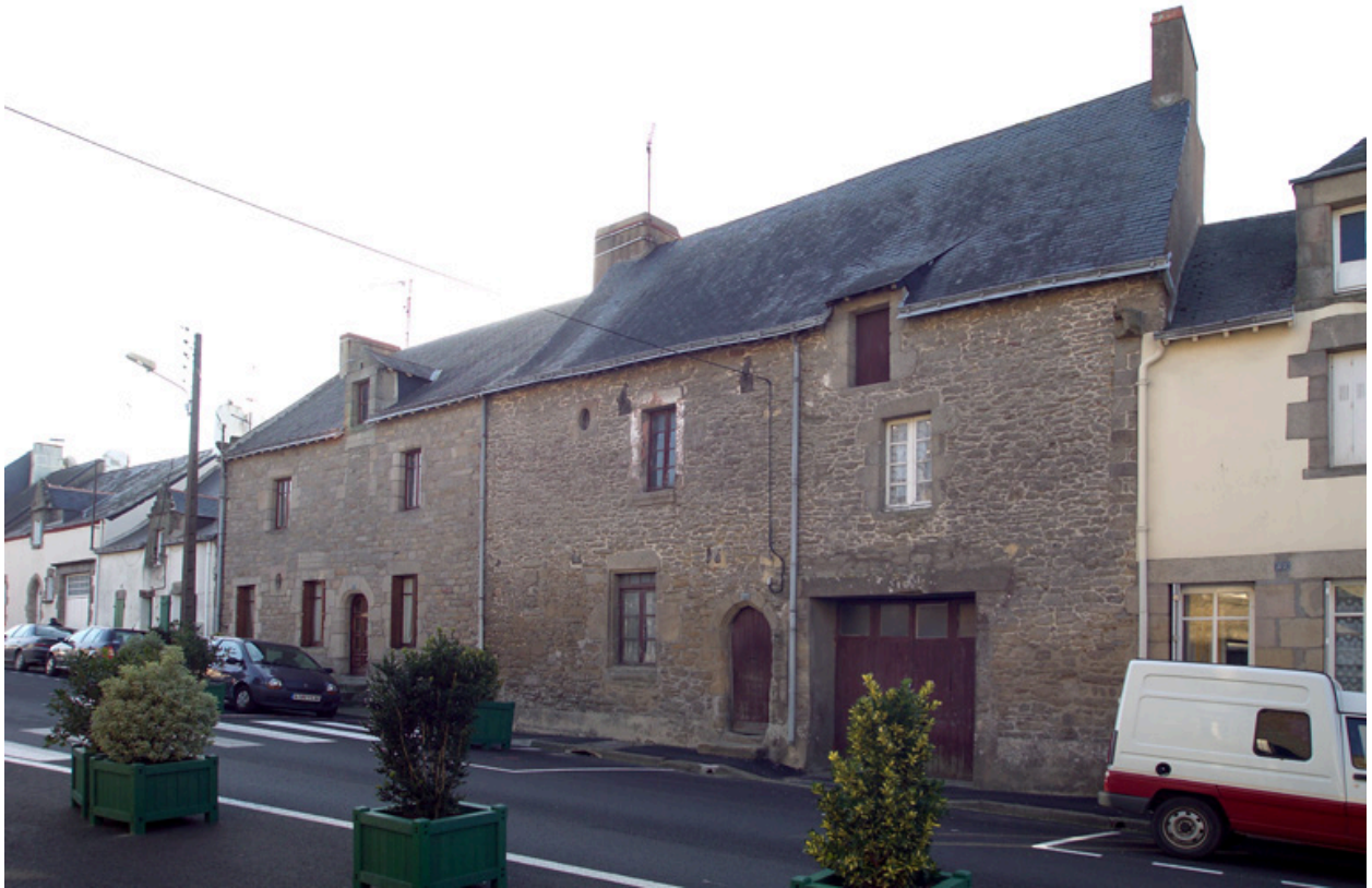
Corps principal, façade nord, vue générale.
