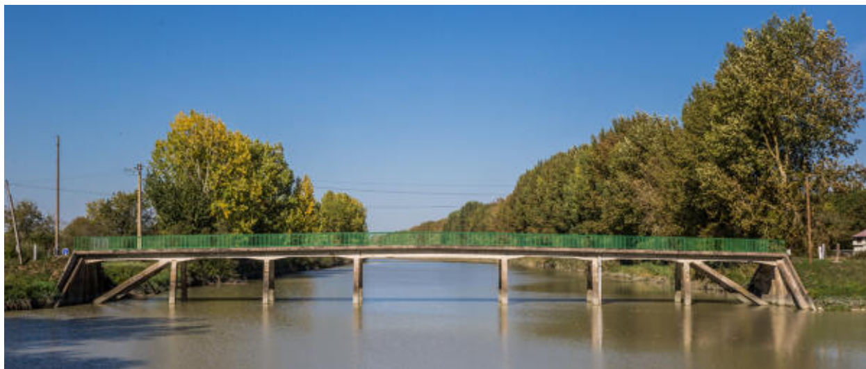
Pont routier franchissant le canal au niveau de la percée de Buzay.
