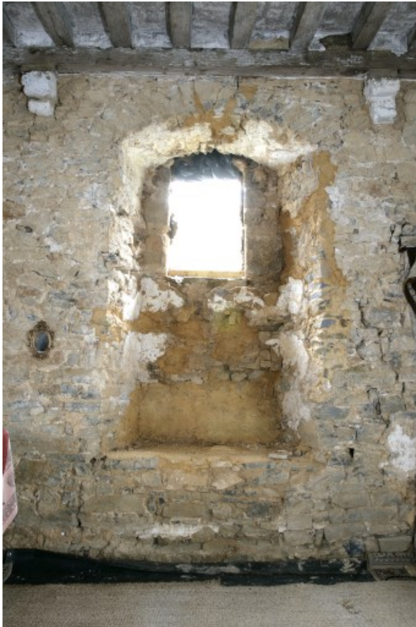
Le logis manorial, salle : la fenêtre sud.
