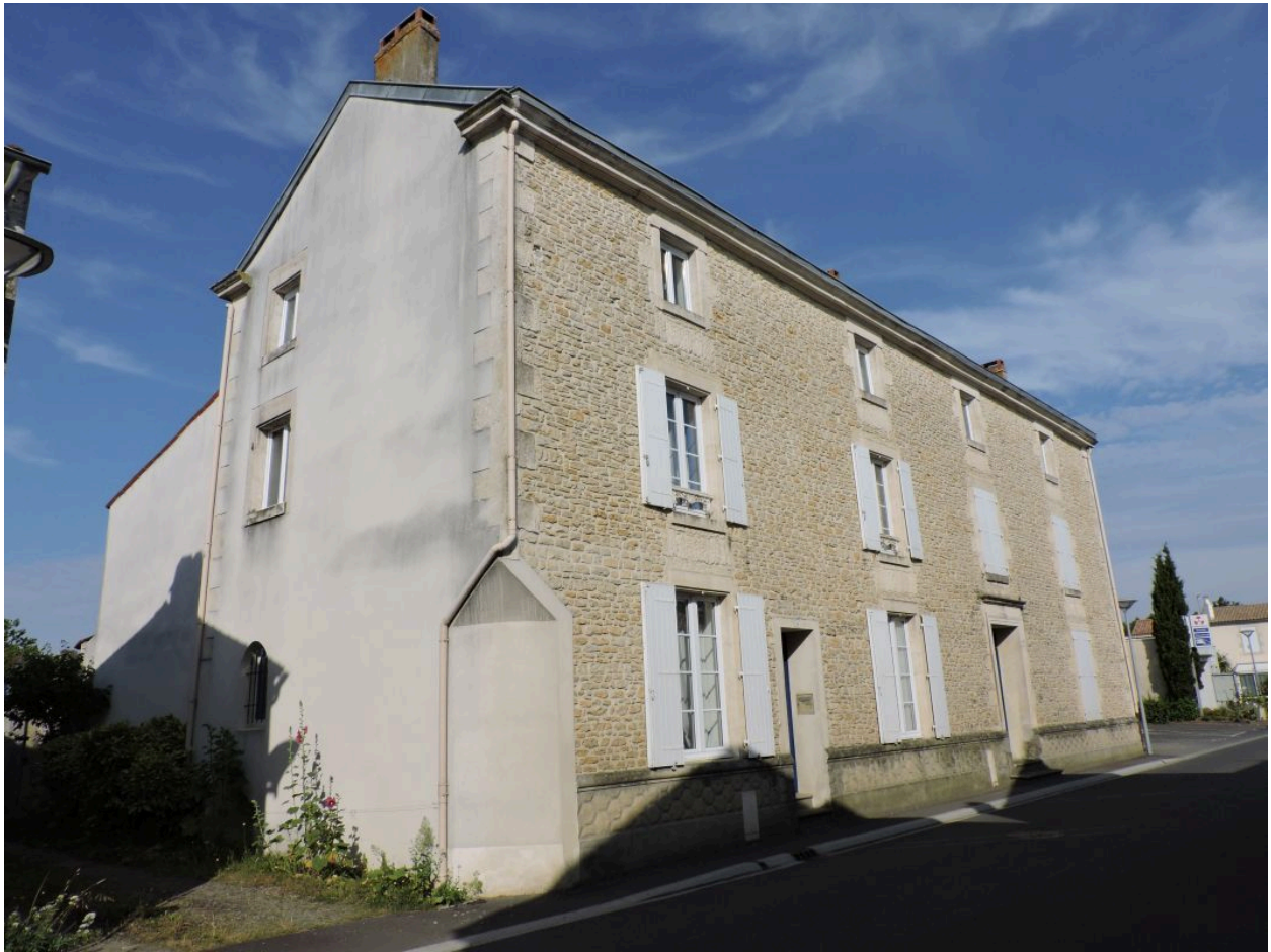
La maison vue depuis l'est.
