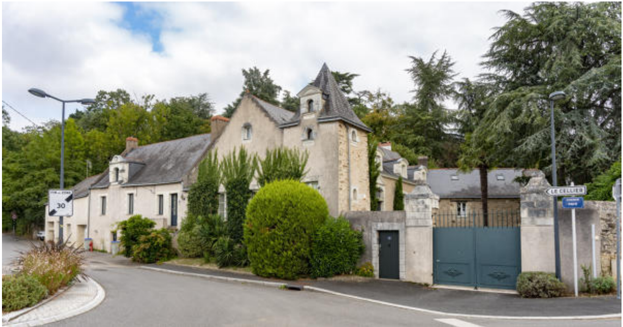
Ensemble de deux maisons, 2 et 4 chemin Pavé.
