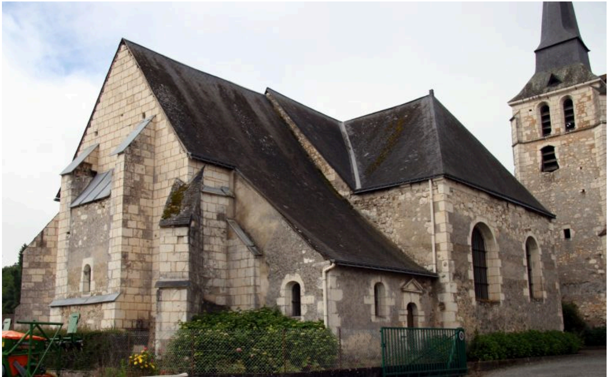
Le chevet et le chœur : vue de volume prise du nord-est.
