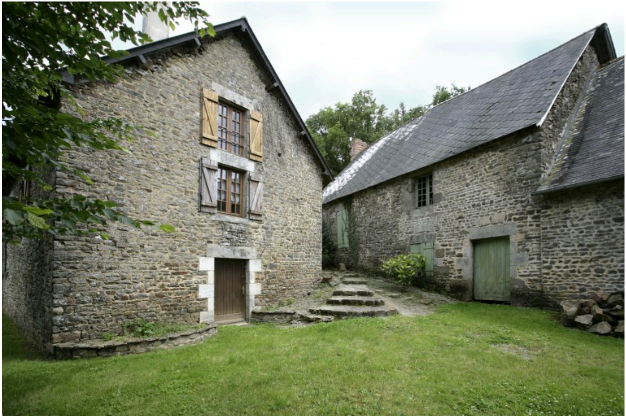
Le pignon ouest du moulin et le logis-dépendance vus depuis le nord-ouest.
