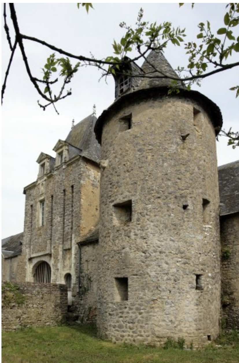
Le pavillon d'entrée et la tour de flanquement vus depuis la douve au sud-ouest.
