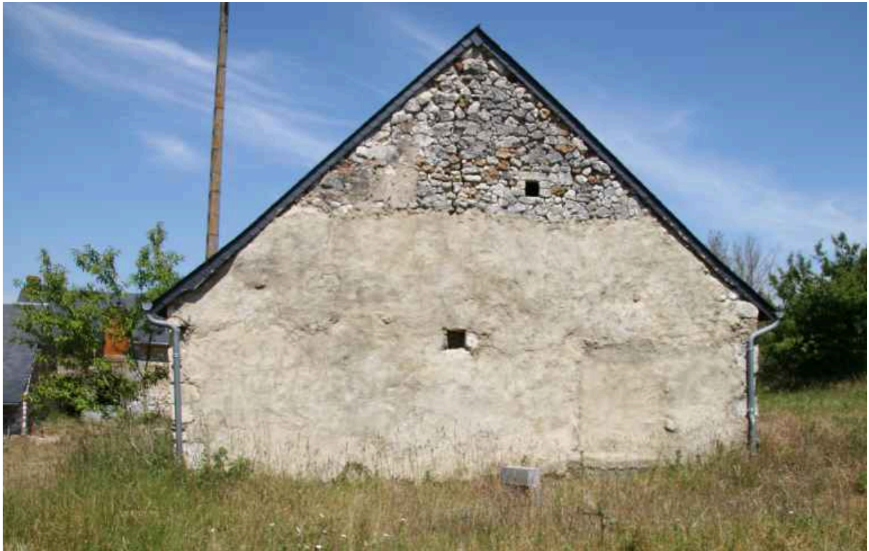
Maison d'habitation : le pignon.
