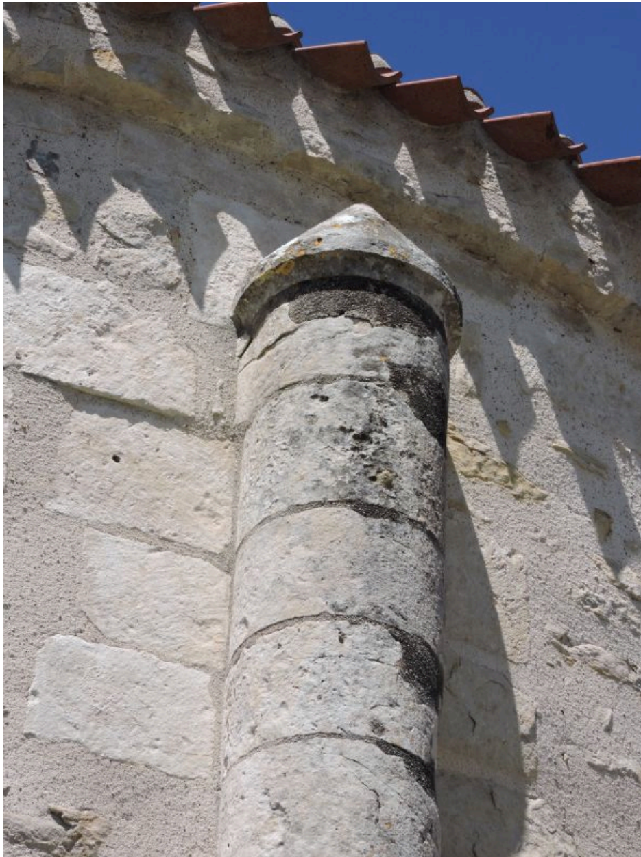
Détail d'une des colonnettes qui flanquent l'abside.
